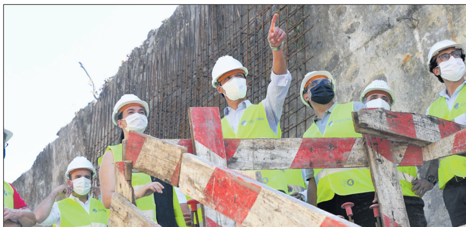
Obra é de alguma complexidade, atendendo a que a entrada principal, a preservar, condiciona a entrada de máquinas e materiais
