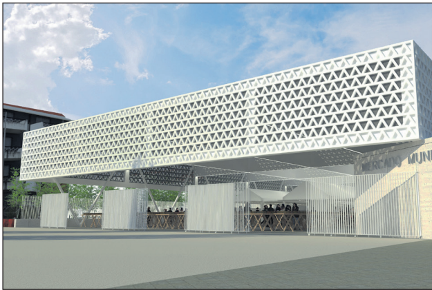
Mercado Municipal é uma das obras em destaque para 2020
