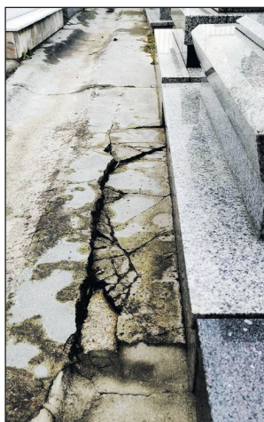
Danos não visíveis nos próprios muros de contenção, mas também nos pisos das imediações, e junto a sepulturas
