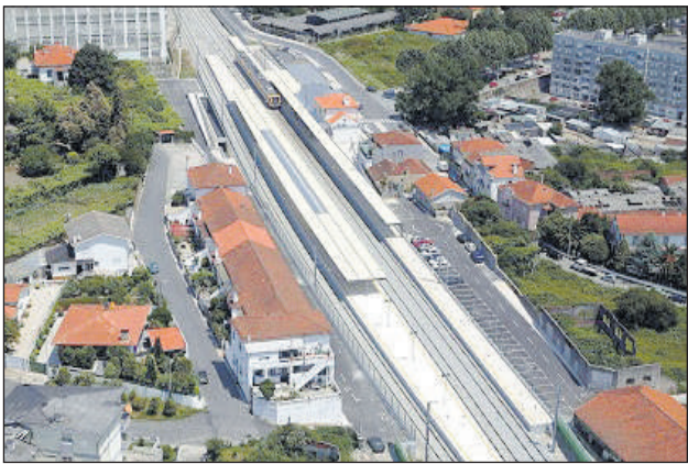
das passagens-de-nível. No âmbito desta operação de melhoramento dos acessos, foram também criadas zonas de estacionamento que até aí eram inexistentes.
